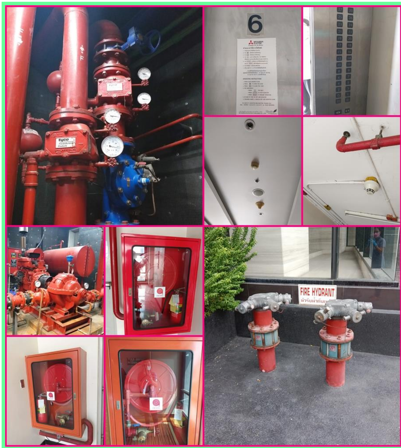
รูปที่ 1.47 ระบบป้องกันอัคคีภัยของโครงการ ประกอบด้วย ระบบท่อเย็น หัวรับน้ำดับเพลิงภายนอก อาคาร เก็บสายฉีดน้ำดับเพลิงพร้อมอุปกรณ์ ระบบดับเพลิงอัตโนมัติ และลิฟต์ดับเพลิง
